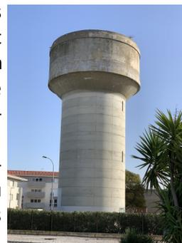
Les travaux porteront essentiellement sur la cuve de stockage. A l'intérieur, les revêtements imperméabilisants et les équipements seront refaits à neuf (canalisations et gardes - corps nouveaux).
